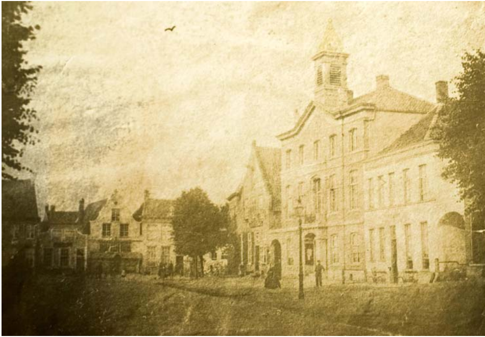
De oudst bewaarde foto van het westelijke deel van de Markt, met daarop centraal het stadhuis. Dat was al lange tijd hier gevestigd maar werd in 1860 vergroot en gemoderniseerd, waarvan het resultaat hier te zien is. Ten noorden ligt het hotel Van Oppen/Tielen, maar een opschrift ontbreekt. Het huis ten zuiden is in 1865 vervangen door een groot nieuw pand, gebouwd in opdracht van de notaris Sassen. De foto is dus omstreeks 1863 gemaakt. (RHCE, fotonummer 104234).
